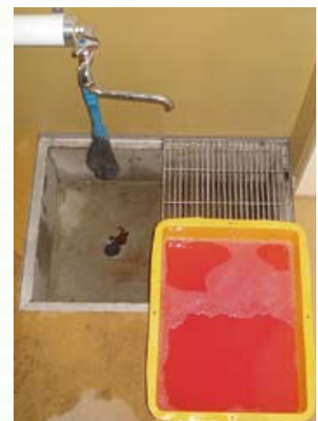
写真2) 洗い場に併設した消毒槽
